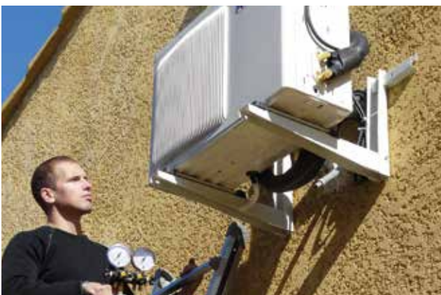
Installation du système de climatisation Maison particulière - Bassin d'Arcachon
