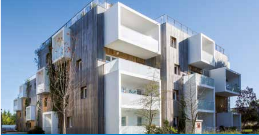
Bâtiment Artigon B - Pessac
