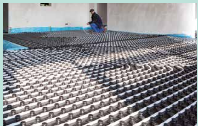
Installation d'un plancher chauffant en maison individuelle
